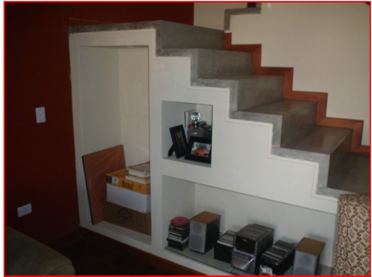
Modelo Febrero con estructura de mampostería y canto protegido
